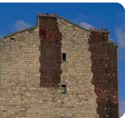
Conduit de cheminée
