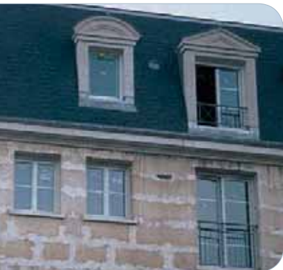
Montage au plâtre
