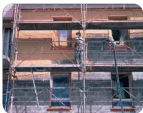
Chantier enduit monocouche
