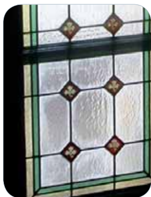
Vitraux d'une cage d'escalier
