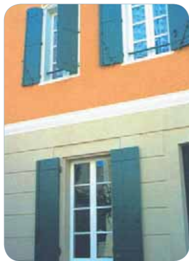
Modénature façade enduite
