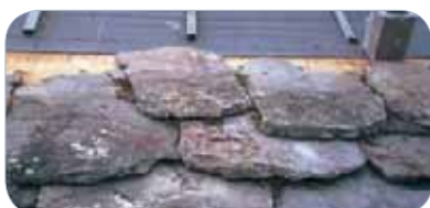
Chantier de couverture en lauzes
