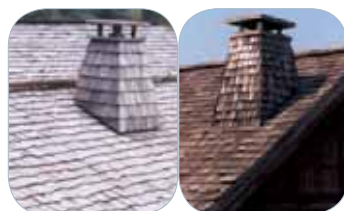
Couverture en bardeau
