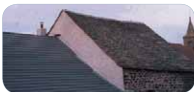
Pentes des couvertures en lauze et tuiles
