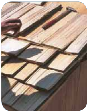
Chantier de couverture en bardeau
