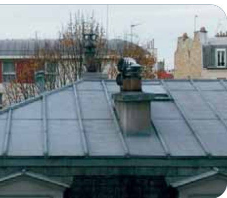
Couverture en feuilles de zinc
