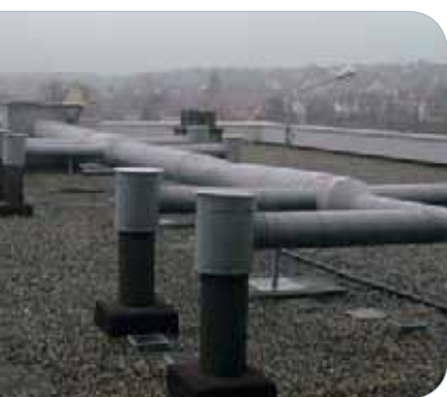
Toiture-terrasse inaccessible avec zone technique
