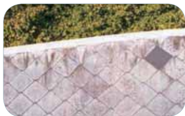
couverture en ardoise artificielle
