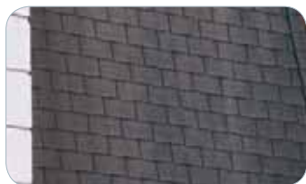
couverture en bardeau bitumé
