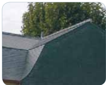
couverture en ardoise
