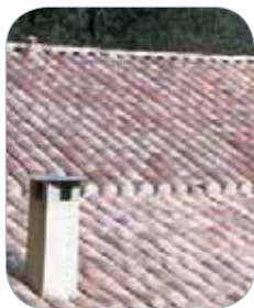
Couverture tuiles canal
