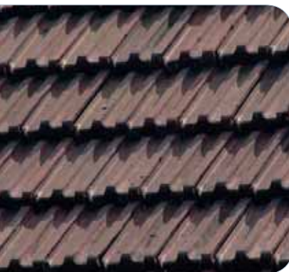
Couverture tuiles à emboîtement
