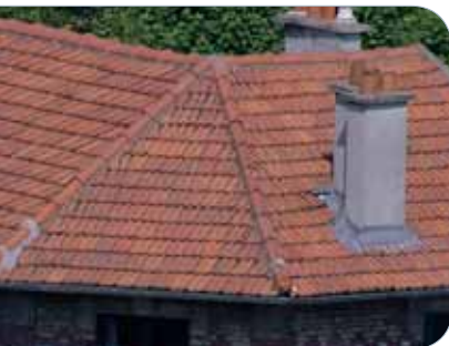
Couverture tuiles à emboîtement
