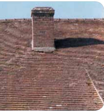
Couverture tuiles plates
