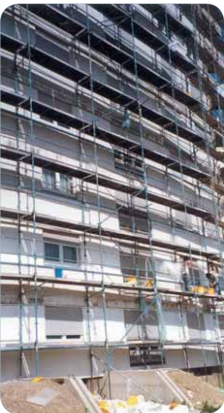
Chantier d'isolation par l'extérieur,
