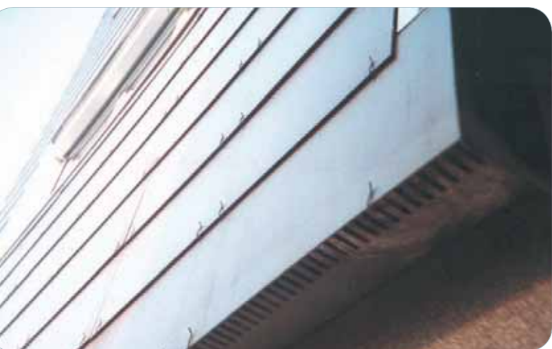
Lames d'air et bas de bardage
