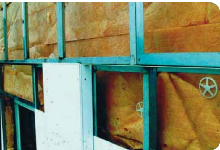
Bardage en cours de montage
