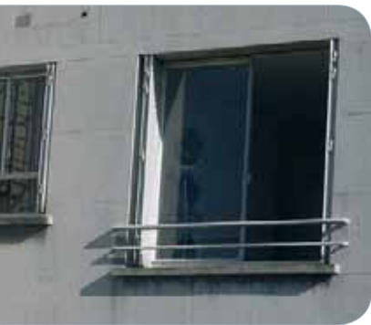
Barre d'appui de fenêtre en tubes d'acier
