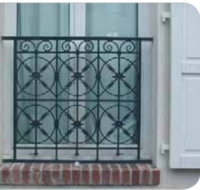
Garde-corps en fonte
